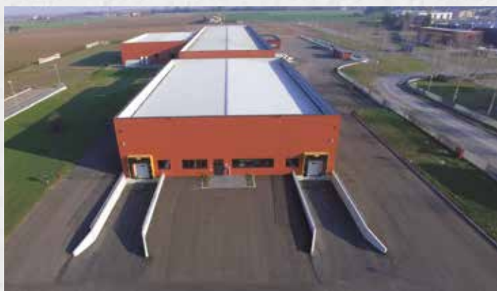
COLLECCHIO - PARMA - STABILIMENTO DEDICATO AL TRATTAMENTO HPP
